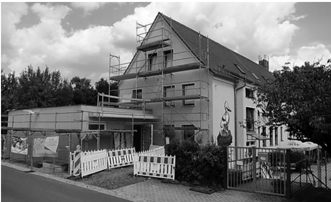
Fassade des Storchennests
