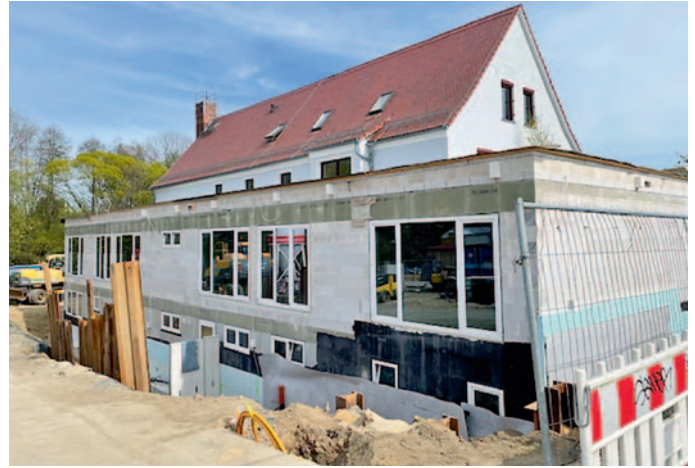
Blick auf den neuen Anbau
