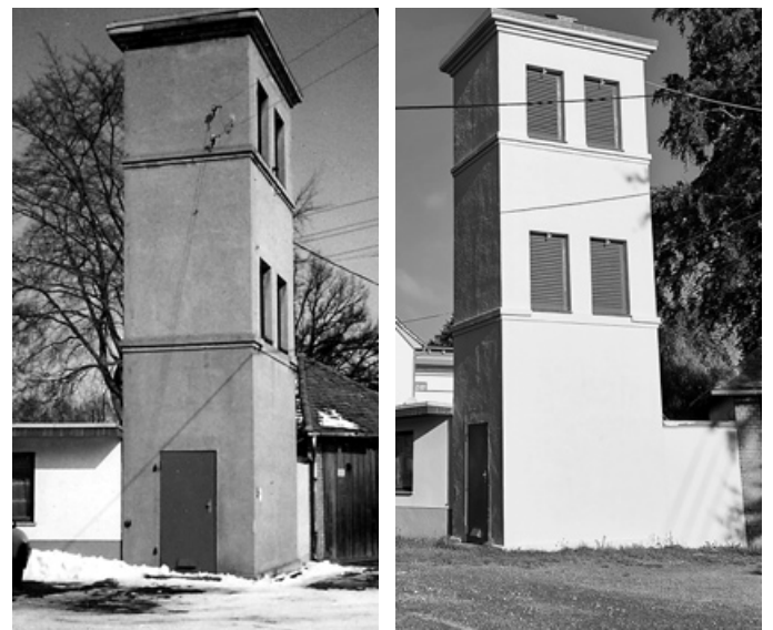
Steigerturm vor und nach der Renovierung
