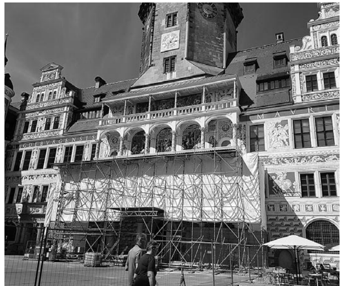
Der große Schlosshof ist teilweise noch im Bau
