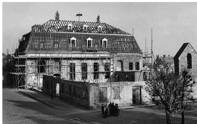
30.10.1951: Richtfest Kirchensaal Herrnhut, Foto: Heimatmuseum Herrnhut
