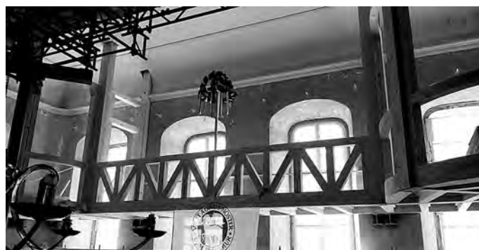
Fachwerk für die Schwesternempore
