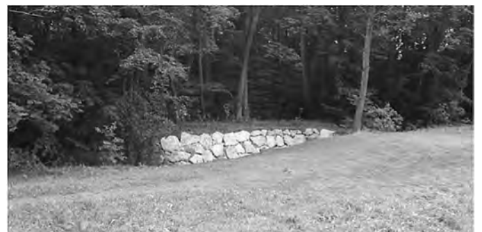
neu errichtete Uferbefestigung
