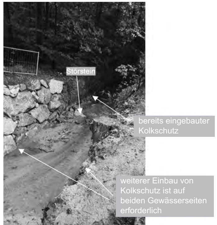
Unterspülung der gegenüberliegenden Ufermauer direkt am Schadensort
