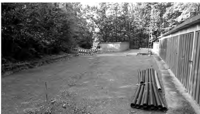
Vorbereitung für den Straßenbau
