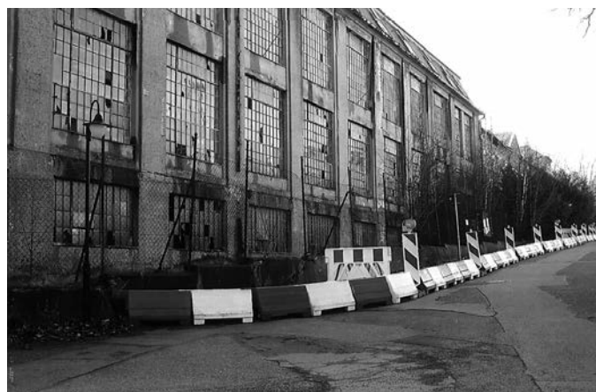
Dies ist eine weitere Sicherungsmaßnahme (Verkehrseinschränkung) innerhalb der Ortslage von Berthelsdorf entlang der Kreisstraße von Herrnhut nach Bernstadt
