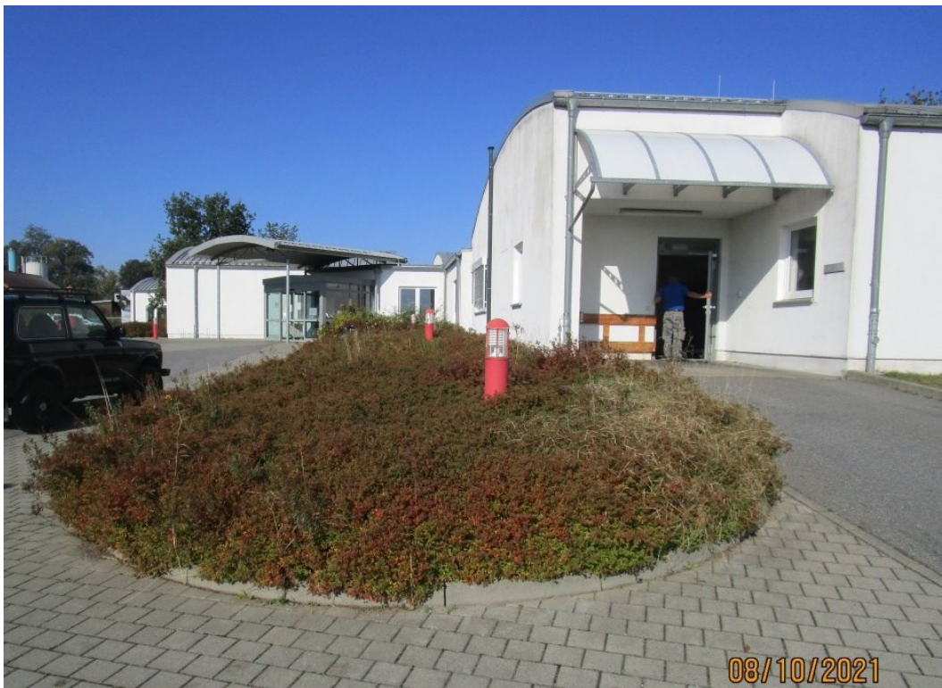
Abbildung 5: gestaltete Abstandsfläche (Pfb.) vor Gebäude der WfbM (SO1a), (Quelle: IBOS GmbH)
