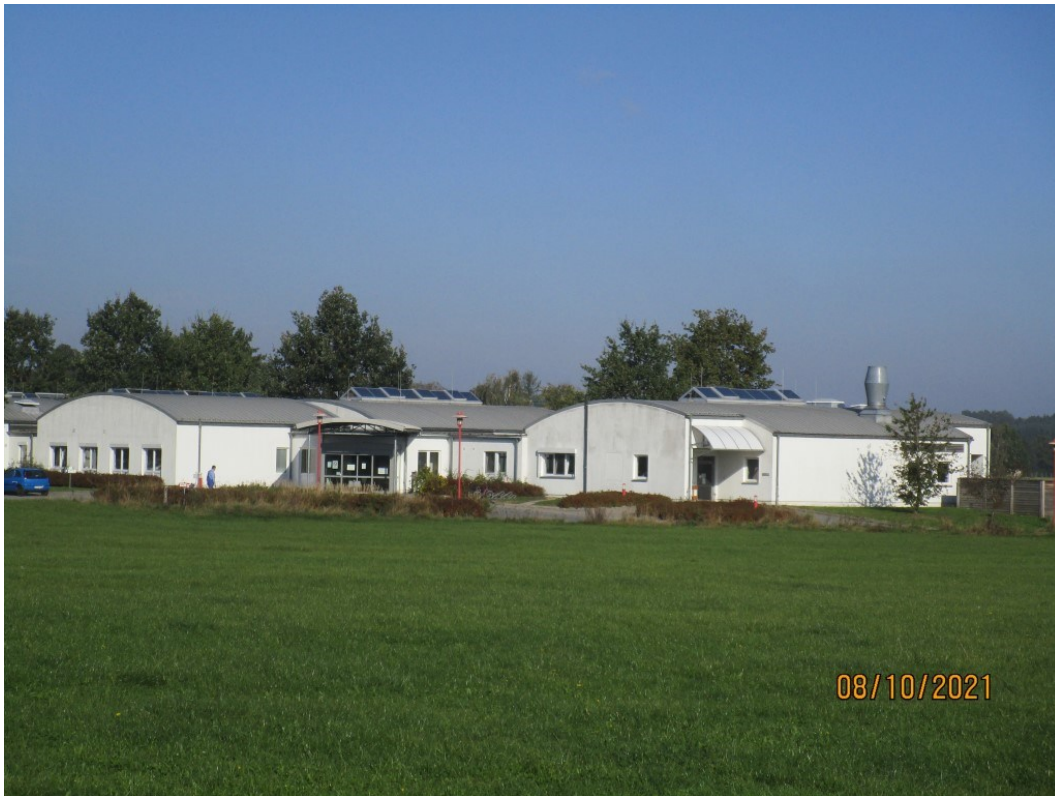
Abbildung 4: Blick von zukünftigen SO1b mit derzeit Intensivgrünland auf Gebäudebestand der WfbM (SO1a) (Quelle: IBOS GmbH)
